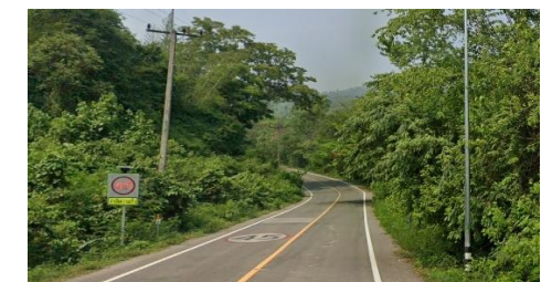
12 ทางหลวงชนบท su.4064
