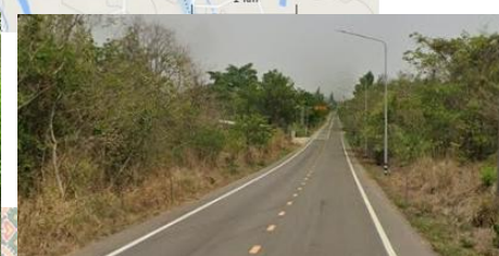
3 ทางหลวงชนบท su.4066
