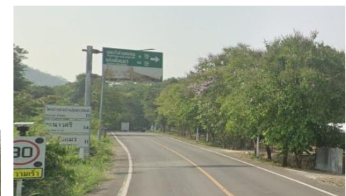
6 ทางหลวงชนบท su.4064
