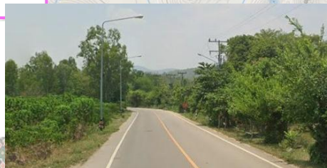
1 ทางหลวงชนบท su.4041
